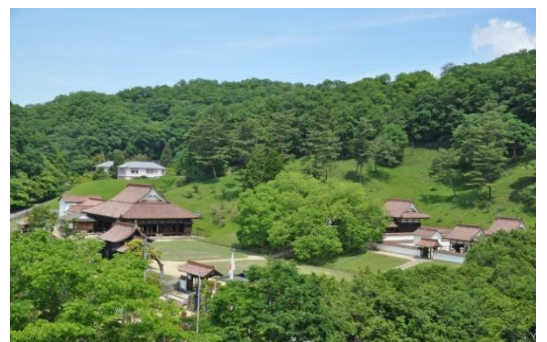
写真 3-5 自然と共生する場に営まれた閑谷学校
